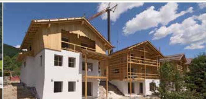
BAUMEISTERARBEITEN: Chalets Liondes, St. Vigil in Enneberg
